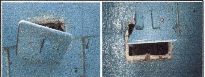
Foto 4: Sustitución de interruptores simples y dobles
