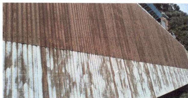
Foto1: Sustitucion de lámina, por lámina troquelada aluzing calibre 26
